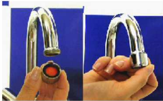
Mise en place d' un mousseur sur un robinet. Source: Ecoperl
