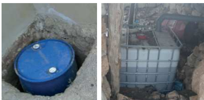
Figure 4: Réservoirs (1000 L à gauche, 200 L à droite) de stockage d'urine en matières plastiques utilisés à Dayet Ifrah, Maroc (source: M. E. Khiyati, 2012).
