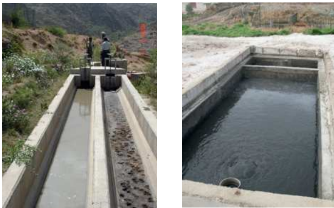
Figure 3: A gauche: Canal dessablage à la station de la ville de Hajja, Yemen (à gauche: canal en fonctionnement; à droite: canal mis en repos avec sable accumulé en séchage avant évacuation) (source: El Hamouri, 2004). A droite: Canal de dessablage en amont d'un filtre planté à Haran-Al-Awamiéd près de Damas, Syrie (source: E. von Muench, 2009).
