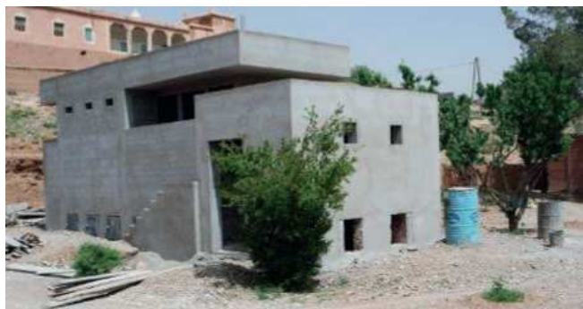
Figure 5: TDSU en cours de construction dans une école à Aït Idir (source: C. Brand, April 2015).
