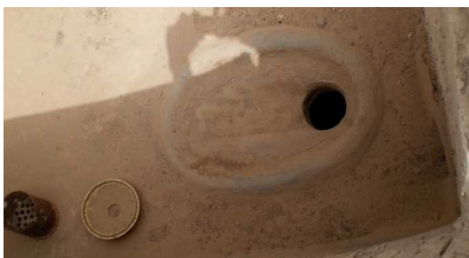
Figure 4: Cuvette simple équipant une latrine traditionnelle au Burkina Faso (source: A. Fall, 2009).
