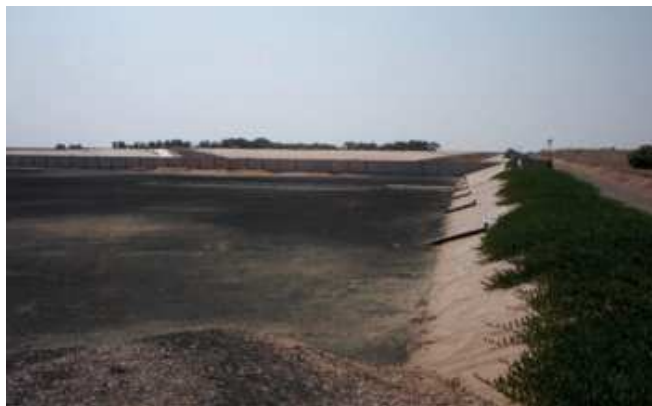
Figure 5: Filtre à sable de la station d'épuration M'Zar près de Agadir, Maroc (source: M. Wauthélet, 2001). Le résidu observé à la surface du filtre est principalement composé d'algues séchées.
