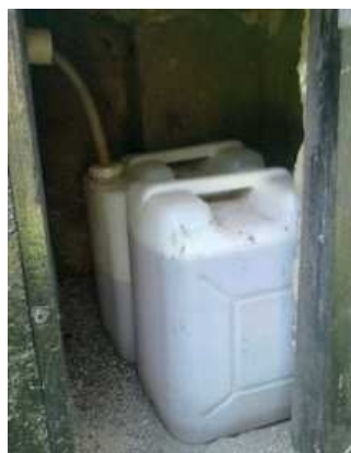
Figure 2: A gauche: Collecte d'urine dans un container en matières plastiques de 20 L (source: H. Hoffmann, 2009). A droite: Container de 20 l placé dans une loge additionnelle en Zambie; à noter que le diamètre du tuyau de collecte est trop faible (source: R. Ingle, 2010).
