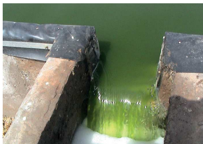
Figure 2: Réutilisation des eaux usées traitées à Attaouia après traitement: RAFADE suivi d'un chenal algal et de deux bassins de maturation en série (source: B. El Hamouri, 2007).
