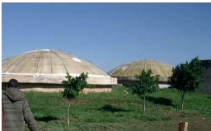
Figure 8: RAFADE du projet El Attaouia; réacteurs couverts à l'aide de coupoles en polyester (source: El Hamouri, 2005).
