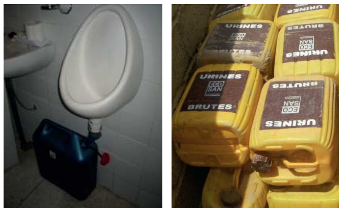
Figure 1: A gauche: stockage d'urine en jerrycan placé sous un urinoir à Dayet Ifrah (source: M. Wauthélet, 2010). A droite: bidons de stockage de l'urine à Ouagadougou, Burkina Faso (source: Tapsoba, 2009).
