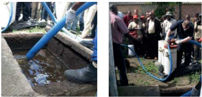
Figure 4: Démonstration du système eVac pour le pompage des boues de vidange de la fosse d'une latrine améliorée ventilées (VIP) (source: E. von Muench, 2012).
