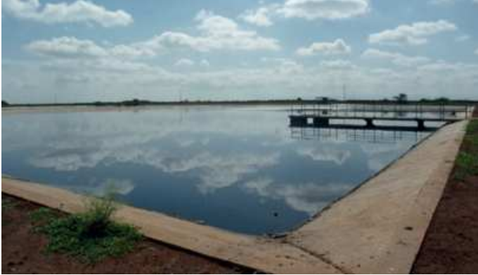
Figure 4: Bassin facultatif dans une station de traitement des eaux usées à Ruai près de Nairobi, Kenya (source: D. Mbalu, 2011).
