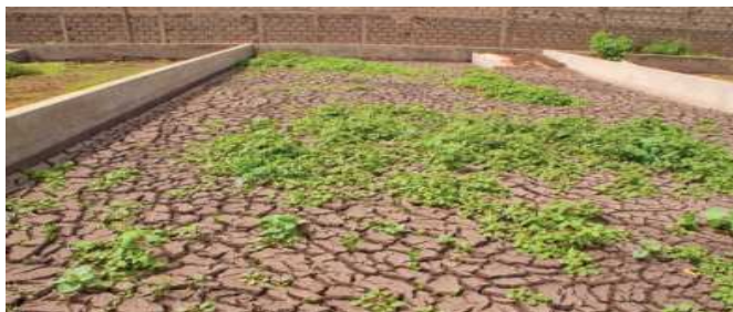
Figure 5: Lit de séchage pour des boues fécales dans une station d'épuration à Camberene, Sénégal (source: L. Strande, 2010).
