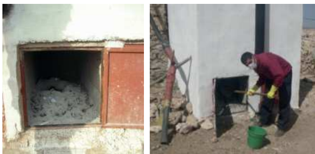
Figure 3: Chambres de déshydratation à Dayet Ifrah. A gauche: Vue des fèces en cours de déshydratation, à droite: vidange des fèces déshydratées (source: GIZ-AGIRE, 2013).
