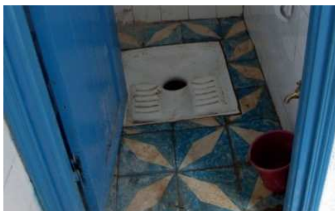
Figure 3: Cuvette en céramique à chasse dans l'école de Dayet Ifrah, Maroc (source: R. Ingle, 2009).
