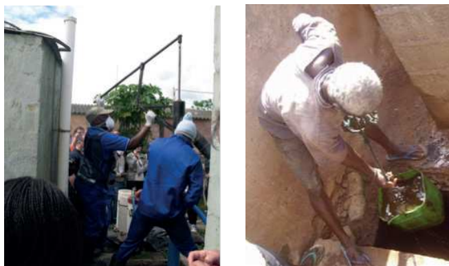
Figure 5: A gauche: Evacuation de boues fécales d'une Ventilated Improved Pit latrine (VIP) à l'aide d'un Gulper à Durban, South Africa; à noter le système à double levier (source: E. von Muench, 2012). A droite: Vidange manuelle d'une fosse simple en utilisant un seau sans vêtements de protection (source: F. Brunner, 2000).
