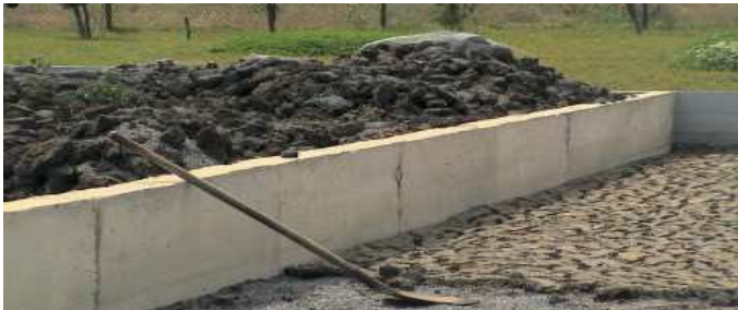
Figure 8: Lits de séchage pour les boues de deux digesteurs anaérobies à la station d'épuration de Skhirat située à 30 km au sud de Rabat (source: B. El-Hamouri, 2006 et 2008).
