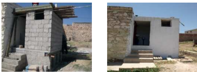
Figure 6: Vue d'une TDSU à Dayet Ifrah, durant la construction (à gauche), Maroc. La toilette contient une douche et est accolée à la maison (source: GIZ/AGIRE, 2010).
