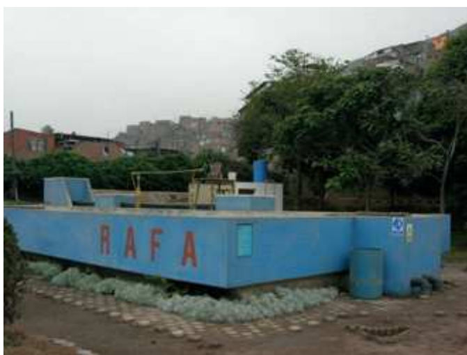
Figure 4: UASB traitant 860 m 3 /j des eaux usées à l'Université UNITRAR à Lima, Pérou (source: LeAF, 2010).
