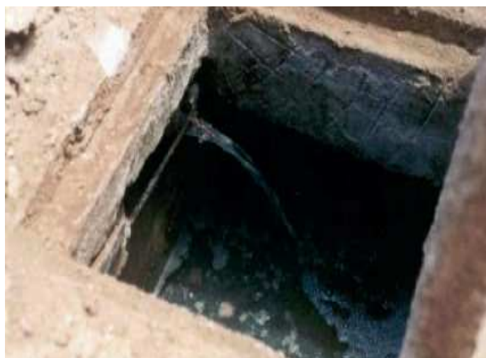
Figure 5: Regard de visite d'une fosse de décantation au niveau de ménage en aval du réseau d'égout décanté, le village Toug El Khir, Maroc (source: B. El Hamouri, 2002).
