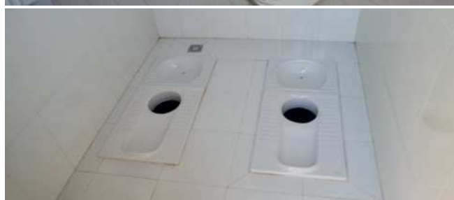
Figure 9: Deux cuvettes à séparation d'urine pour une TDSU à deux chambres à Dayet Ifrah, Maroc (en haut) (source: R. Ingle, 2012) et à Ait Idir, Maroc (source: AGIRE, 2015).
