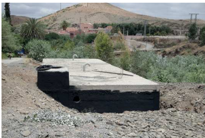
Figure 6: Fosse septique collective construite pour le village de Lalla Takerkoust, Province d'Al Haouz, Maroc (source: B. El Hamouri, 2014).
