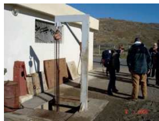
Figure 6: Panier dégrilleur amovible : à gauche: potence et palan de hissage ; à droite: panier en place. Station de lagunage de M'Rirt, Maroc (source: El Hamouri 2005).
