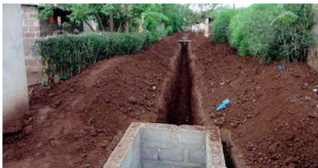
Figure 2: Travaux d'excavation pour la réalisation d'un réseau décanté à Libuyu (un quartier de Livingstone), Zambie. Le réseau comprend des regards de visites, une station de pompage, plusieurs toilettes et dix digesteurs fonctionnant comme décanteurs intermédiaires pour les matières solides (source: P. Feiereisen, 2011).
