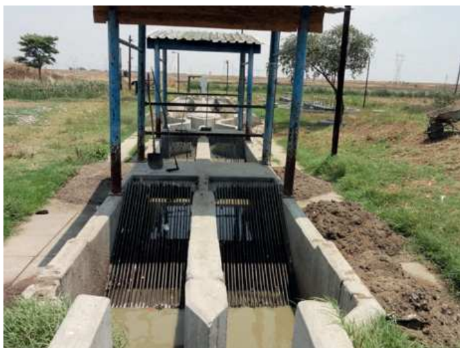
Figure 1: Unité de dégrillage installée dans une station de traitement à Norton, Zimbabwe (source: P. Feiereisen, 2011).
