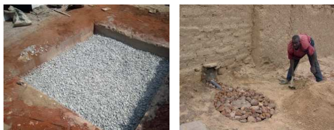
Figure 3: A gauche: Puits d'infiltration pour les eaux de lavage anal d'une TDSU au centre d'éducation Darad dans le Ukunda communauté côtière, Kenya (source: S. Miethig, 2011). A droite: Puits d'infiltration circulaire pour eaux grises en construction au Mali (source: J. O'Keefe, 2011).
