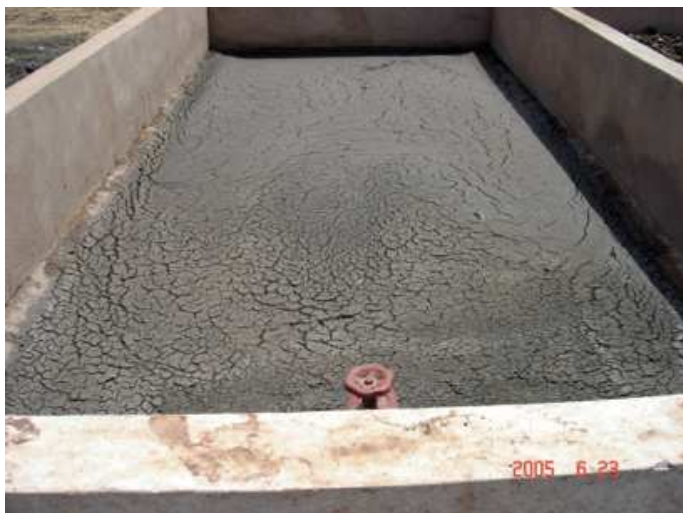
Figure 7: RAFADE du projet El Attaouia: lit de séchage des boues (source: El Hamouri, 2005).
