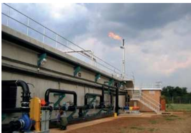
Figure 3: UASB avec torchage de l'excès de biogaz en Afrique du Sud (source: Talbot & Talbot).
