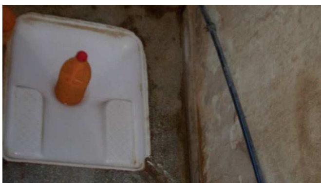
Figure 7: Cuvette simple en céramique sans siphon hydraulique placée dans une toilette rurale avec eau courante au Maroc. Noter l'utilisation d'un bidon en matières plastiques rempli d'eau pour obstruer l'orifice de la cuvette entre deux usages (source: M. Wauthelet, 2012).
