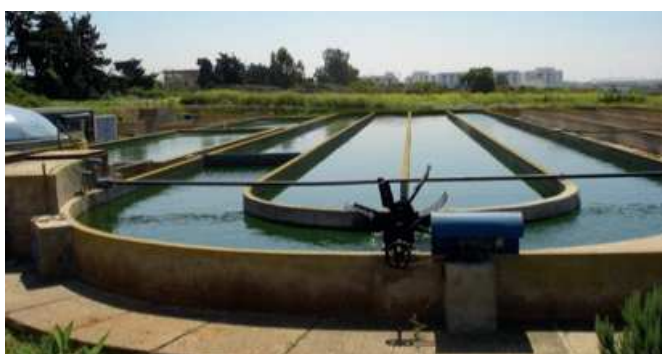
Figure 1: Chenal algal et bassin de maturation de la station prototype de l'IAV à Rabat, Maroc. Chenal algal de 900 m 2 avec roue à palettes. Arrière-plan à gauche: deux bassins de maturation en série (source: B. El Hamouri, 2006).
