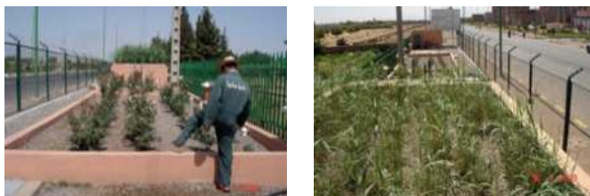
Figure 5: Filtre planté en opération pour le traitement de 30 m 3 /j des eaux grises du hammam de la ville d'El Attaouia sur une superficie de 200 m 2 avec filtre vertical à sable grossier planté de rosiers, et filtre horizontal à gravier et phragmites (source: El Hamouri, 2008).
