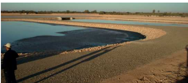
Figure 2: Bassin de lagunage à Tiznit (Maroc) (source: M. Wauthelet, 2009).
