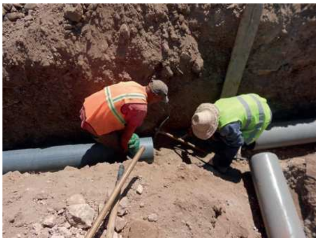
Figure 6: Travaux de pose de conduites d'un réseau d'égout conventionnel à la Commune rurale de Douirane, Maroc (source: DRPE, 2013).
