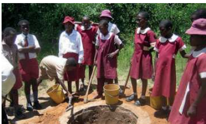
Figure 5: Construction d'une fosse simple pour un « Arborloo » à Zimbabwe (source: P. Morgan, SuSanA, 2009)
