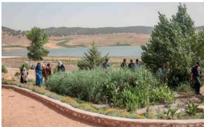
Figure 3: Filtre planté de roseaux et de fleurs (canas) pour une école et une mosquée à Dayet Ifrah, Maroc (source: GIZ-ACIRE, 2012).
