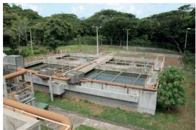
Figure 2: Avant plan: Réacteur UASB de 15.000 EH pour le traitement des eaux usées domestiques. Arrière plan: lits de séchage des boues. Localité de San Juan del Sur, Nicaragua (source: PROATAS/GIZ - AKUT).
