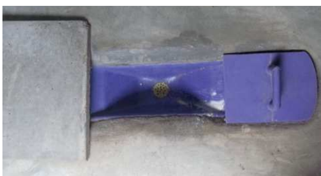
Figure 7: Cuvette à séparation d'urine pour une TDSU avec deux chambres de déshydratation sans section de lavage anal à Nairobi, Kenya; l'orifice d'évacuation de l'urine est commun aux deux orifices pour fèces dont seul celui de droite est en utilisation (source: E. von Muench, 2013).
