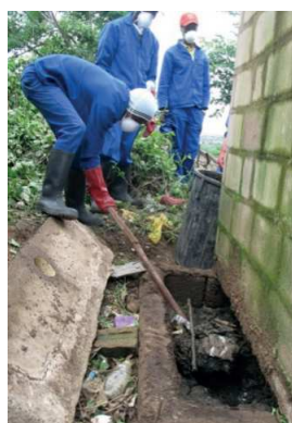
Figure 1: A gauche: Vidange manuelle d'une fosse de latrine traditionnelle à Durban, Afrique du Sud (source: E. von Muench, 2012); A droite: Outils utilisés pour la vidange des fosses de latrines traditionnelles à Durban, Afrique du Sud (source: WRC, 2012).
