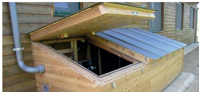
Figure 3: Chambre de compostage associée à la toilette à compost pour un ménage en France (source: E. Le Douarin, 2010).
