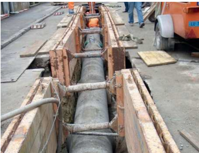
Figure 3: Construction d'un réseau d'égout conventionnel à Luzern, Suisse (source: Wipfli & Partner AG).
