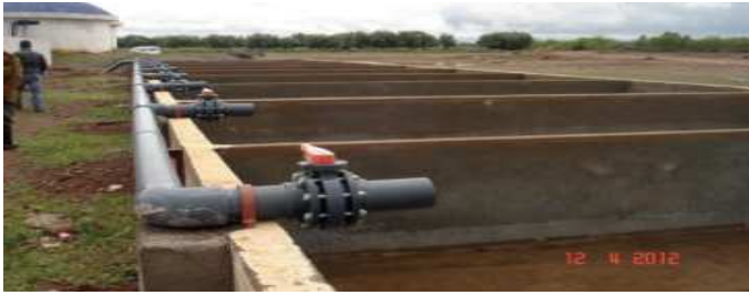
Figure 7: Batterie de 11 lits de séchage en construction pour l'extension de la station d'El Attaouia en 2012 (source: B. El-Hamouri, 2006 et 2012).
