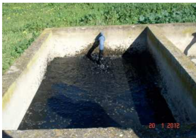
Figure 6: RAFADE de l'Institut Agronomique et Vétérinaire Hassan I, Rabat (IAV): élimination quotidienne des boues excédentaires (source: B. El Hamouri, 2012).
