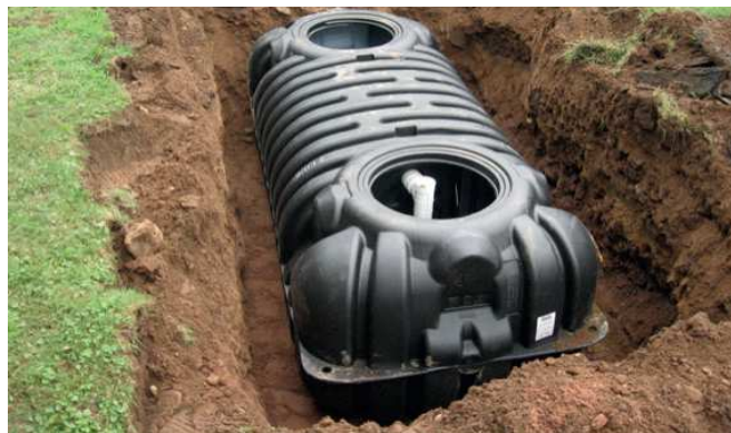
Figure 3: Fosse septique préfabriquée pendant la phase de mise en place, USA (source: Skips Septic Tank Service, Inc., 2013).
