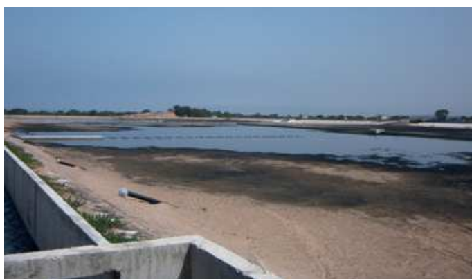
Figure 3: Filtre à sable à M'Zar STEP près de Agadir, Maroc, juste après une bâchée (source: M. Wauthélet, 2001).
