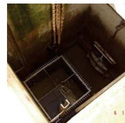
Figure 6: Panier dégrilleur amovible : à gauche: potence et palan de hissage ; à droite: panier en place. Station de lagunage de M'Rirt, Maroc (source: El Hamouri 2005).
