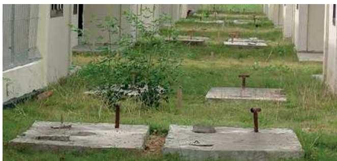
Figure 4: Fosses septiques derrière des habitations en Indonésie (source: Norm van't Hoff, 2003).
