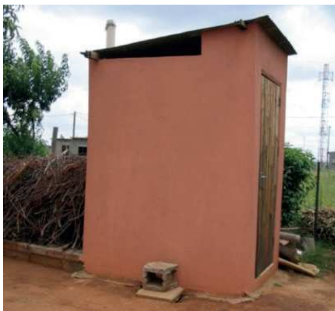
Figure 4: Latrine traditionnelle munie d'un conduit de ventilation à Maseru, Lesotho (source: E. von Muench, 2006).
