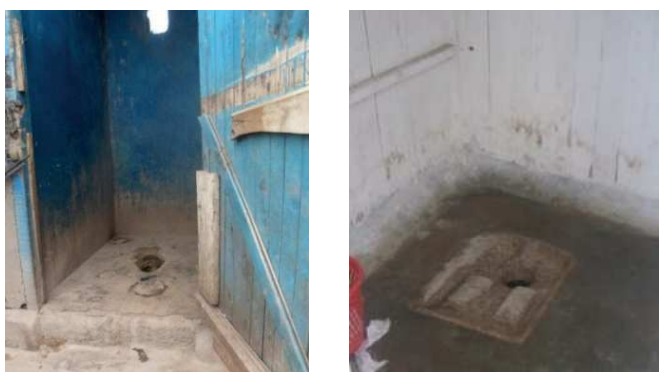
Figure 3: A gauche: Latrine traditionnelle à Nairobi, Kenya (source: D. Mbalu, 2012). A droite: Repose-pieds et trou de défécation installés sur une latrine traditionnelle à Lima, Pérou (source: C. Olt, 2009).
