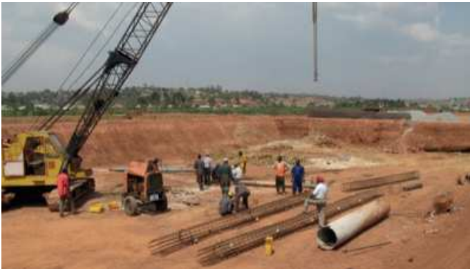
Figure 3: Bassins facultatifs en construction dans la station d'épuration de Lubigi à Kampala, Uganda (source: E. von Muench, 2012).
