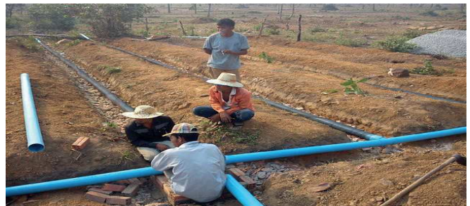
Figure 2: Tranchées d'infiltration en installation par Camps International au Cambodge (source: Arkitrek).
