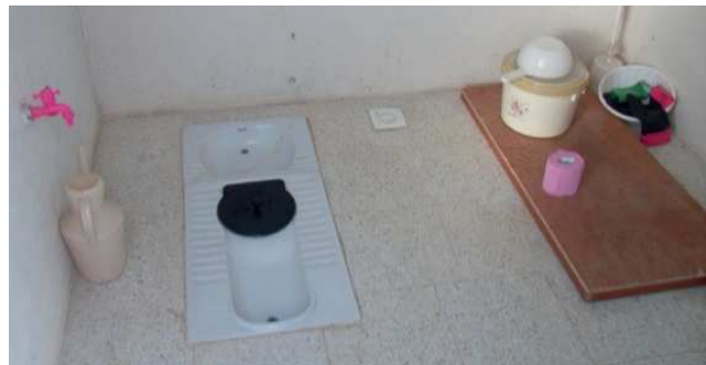
Figure 2: Cuvette à séparation d'urine d'une double TDSU dans une maison à Herat, Afghanistan. Le pan en bois à gauche couvre la deuxième cuvette située sur le second orifice de défécation (source: N. Khawaja, 2010).
