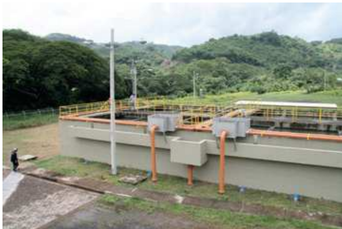
Figure 6. Réacteur UASB pour les eaux usées de 36.000 EH à Boaco, Nicaragua (source: PROATAS/GIZ – AKUT).
