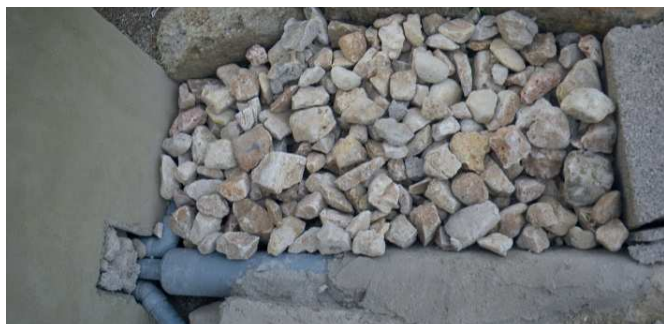
Figure 5: Puits d'infiltration pour l'eau de lavage anal d'une toilette TDSU à Dayet Ifrah, Maroc (source: M. E. Khiyati, 2009).
