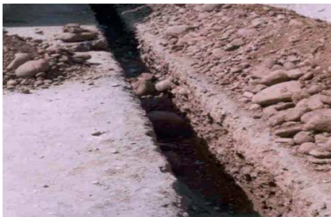
Figure 3: Travaux de réalisation d'un réseau décanté dans le village d'Ait Faska, Maroc (source: B. El Hamouri, 2003).
