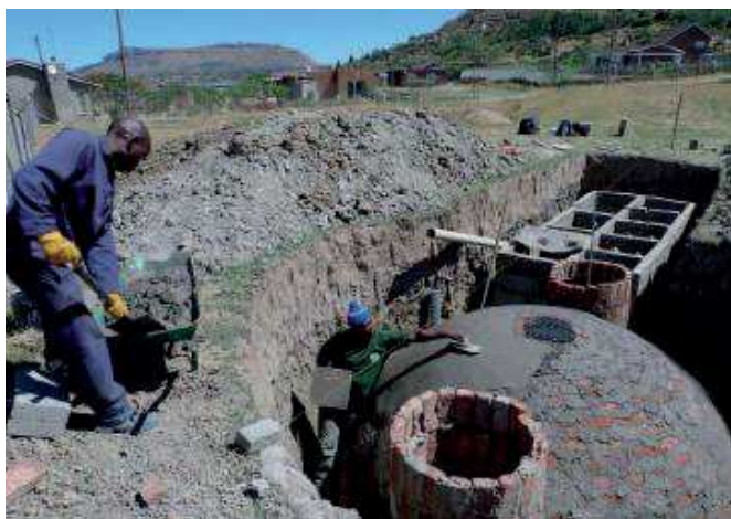
Figure 6: RAC (arrière plan) précédé d'un digesteur (premier plan) avant remblais au Lesotho (source: TED, 2011, Sustainable Sanitation Practice Journal Issue 9).
