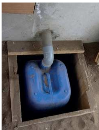
Figure 2: A gauche: Collecte d'urine dans un container en matières plastiques de 20 L (source: H. Hoffmann, 2009). A droite: Container de 20 l placé dans une loge additionnelle en Zambie; à noter que le diamètre du tuyau de collecte est trop faible (source: R. Ingle, 2010).
