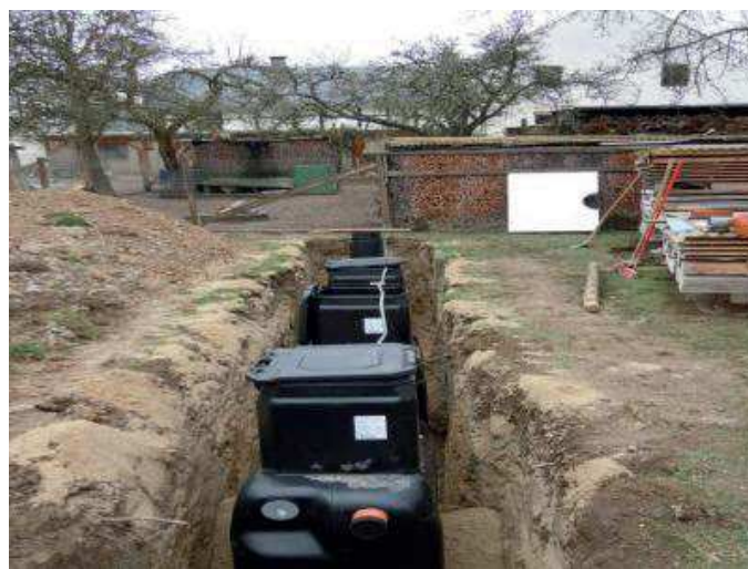
Figure 5: Mise en place des éléments préfabriqués en plastique de petite taille d'un RAC à Thüringen, Allemagne (source: AquaVerde, 2012).
