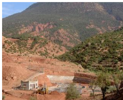
STEP en cours de réalisation, Douar Tassalmat CR Asni
