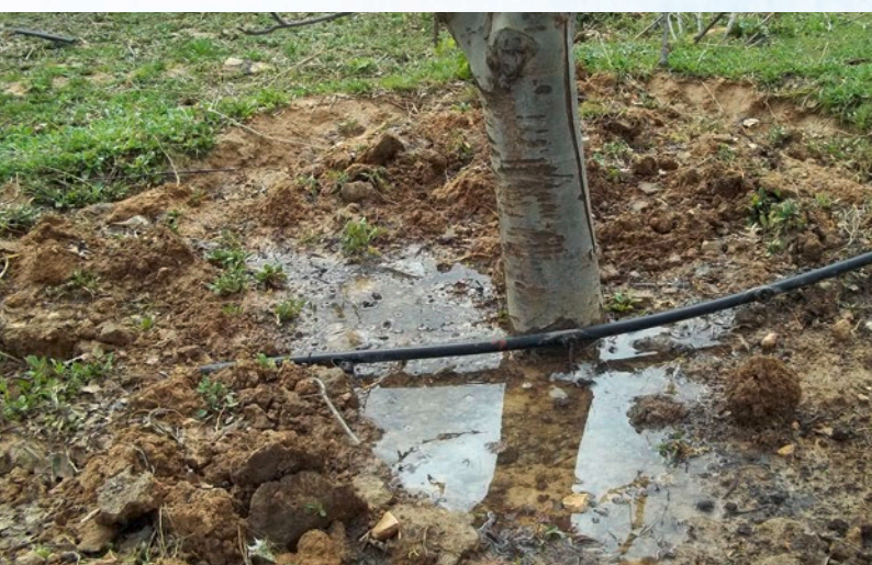
Photo 7 Mauvais fonctionnement des goutteurs
