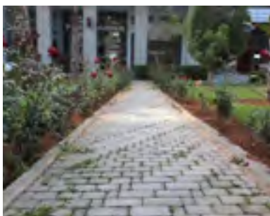
04. Pavé drainant et chaussée réservoir
