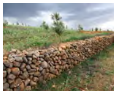
44. Mur de soutènement en pierres
