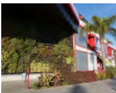
02. Mur vert / végétalisé
