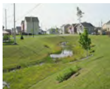
10. Bassin de rétention ou d'infiltration
