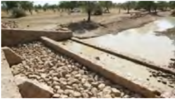
Figure 3 : Déversoir d'un seuil d'épandage suivi du bassin de dissipation, Tchad (Source : Picard, GIZ)
