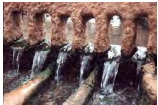
Figure 10 : Khattara (Foggara) en Algérie, munie de peignes (Kesria) (Source : https://fr.wikipedia.org/wiki/Qanat )
