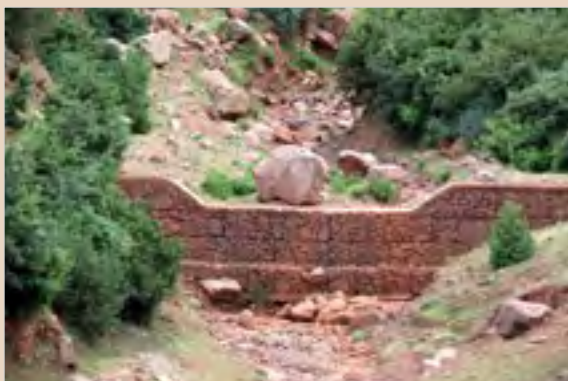
Figure 11 : Mur en gabion (Source : HCEFLCD)
