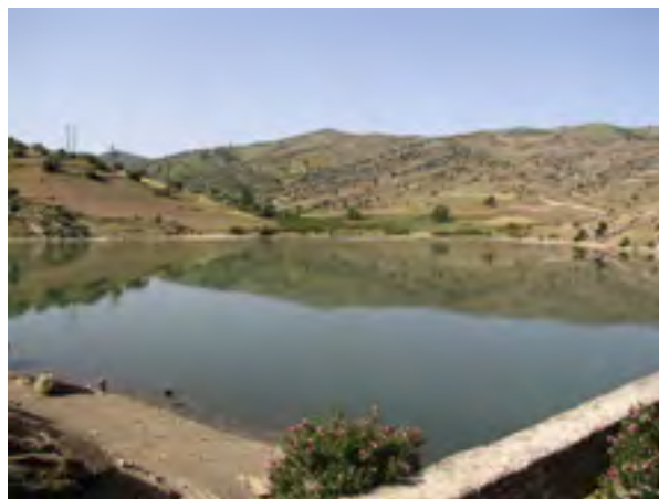
Figure 2 : Lac collinaire dans la région nord Marocain installé pour contrer le problème d'envasement d'un barrage en aval (Source : http://www.ma.auf.org/erosion/chapitre1/VI.Lutte.html )
