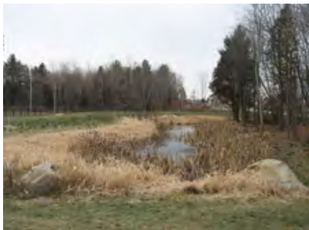
Figure 3 : Bassin de rétention et de régulation, Québec, Canada ( http://www.vsj.ca/fr/bassin-de-retention-du-parc-schulz.aspx )
