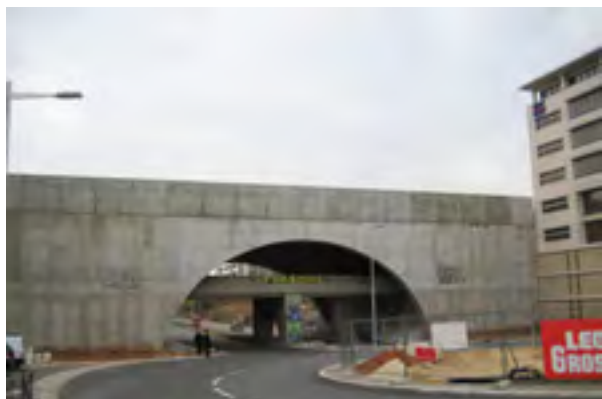
Figure 3 : Pont Max-Juvenal avant le mur végétal, Aix-en-Provence
