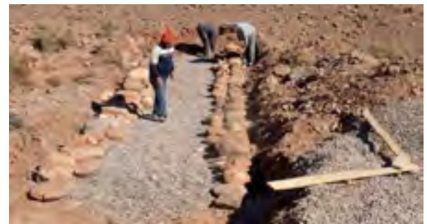
Figure 4 : Construction du seuil d'infiltration au village de Tidrhest (Source : GIZ/AGIRE)
