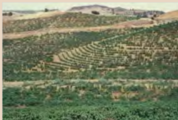
Figure 14 : Série de murs en maçonnerie le long d'un ravin reboisement suivant les courbes de niveau (Source : HCEFLCD)
