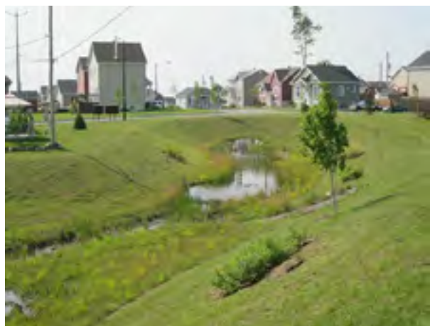
Figure 1 : Bassin de rétention dans un lotissement, Québec, Canada (Source : http://www.cageq.ca/documents/Recommandations_bassins_ancienne.pdf )
