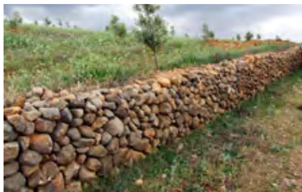
Figure 1 : Mur de soutènement en pierres sèches au bassin versant Allal El Fassi région de Sefrou (Source : Berhili, 2014)
