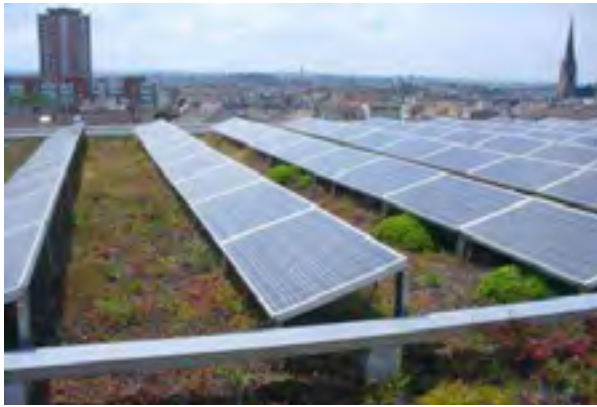
Figure 8 : Toiture mixte : végétaux et panneaux photovoltaïques, Bâle, Suisse (Source : Inter-Environnement Bruxelles)
