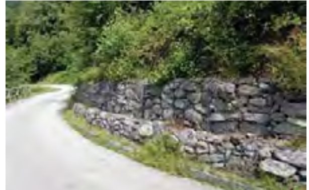
Figure 1 : Mur de soutènement en gabions protégeant la route du talus (Source : Meyer et al. 2011)
