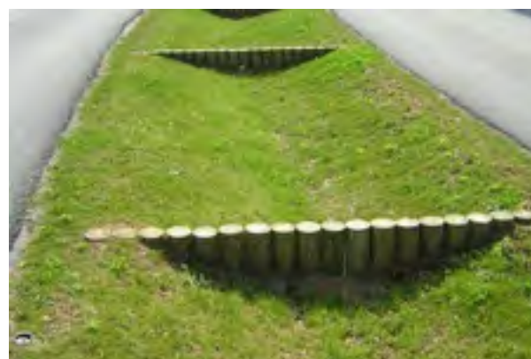
Figure 7 : Noue cloisonnée ( https://www.amiens.fr/content/download/3325/51310/file/Guide-Public.pdf )
