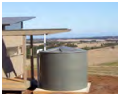
13. Collecte de l'eau de toiture
