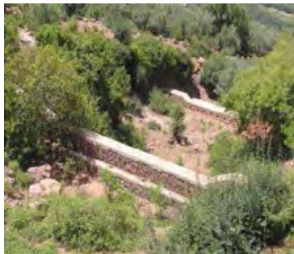
Figure 6 : Seuils en gabions végétalisés, bassin versant de l'Ourika - Maroc (Source : Blali, 2011)
