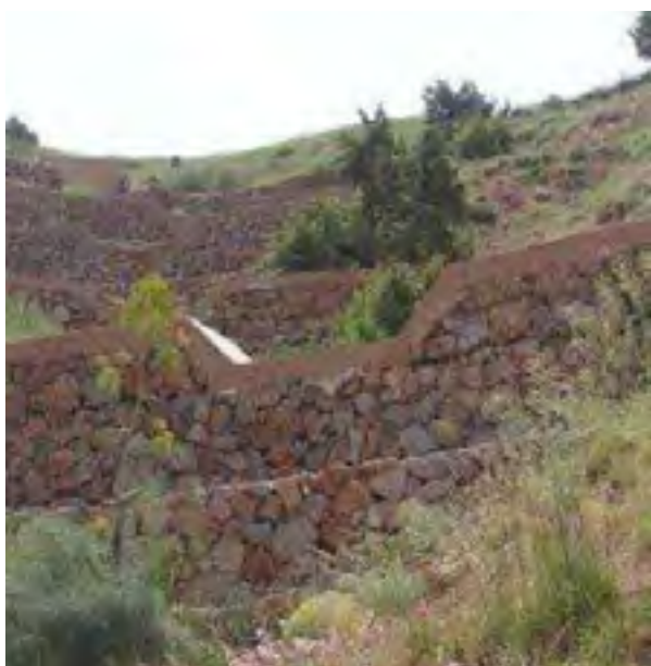
Figure 5 : Série de seuils en gabions, région d'El Kbab - Maroc (Source :Blali, 2011)
