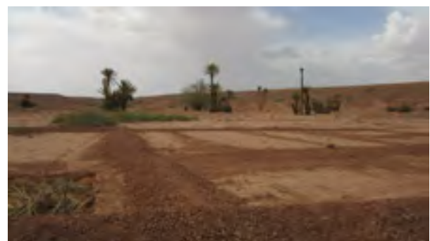
Figure 6 : Etat final des negarims au village de Tidrhest pour la plantation des oliviers (GIZ, 2013)
