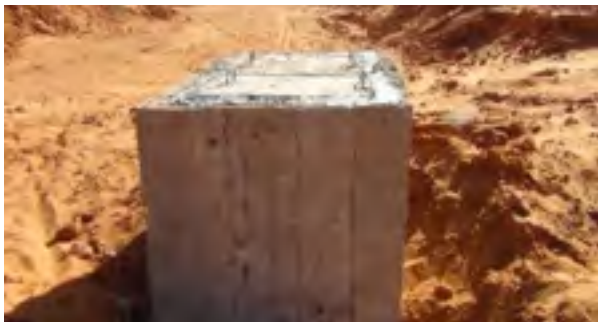
Figure 8 : Réhabilitation des puits d'une khattara, Gelmima
