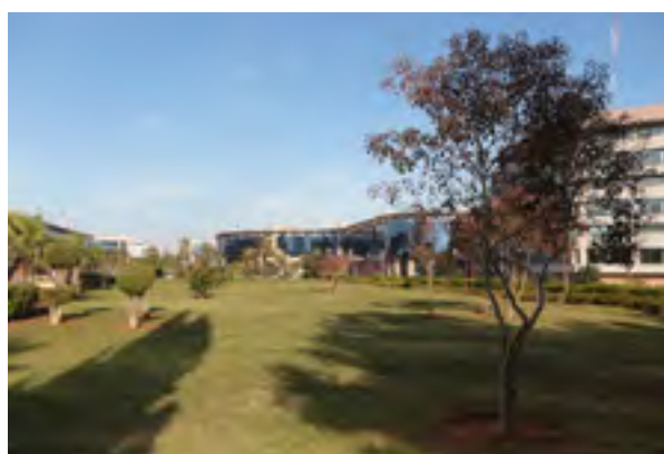
Figure 7 : Toiture végétalisée du parking végétal de Hay Riad, Maroc (Source : Compagnie Générale des Parkings – Groupe CDG)
