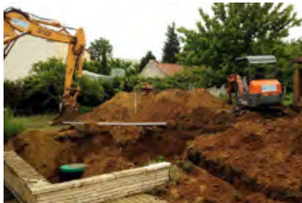
Figure 4 : Creusement des tranchées pour la disposition des tuyaux de descente (Source : https://blog-maison-ecologique.fr/maison-ecologique/maison-ecologique-installation-dune-cuve-enterree-de-recuperation-deau-de-pluie )
