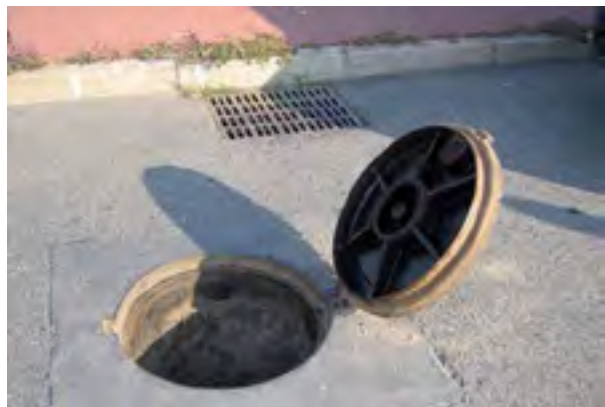
Figure 1 : Puits d'infiltration avec tampon ouvert et regard de décantation (Source : Grand Lyon, 2008)
