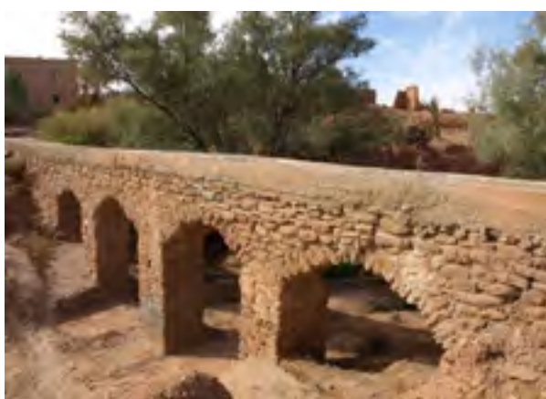
Figure 9 : Réhabilitation de la Séguia du village de Tidrhest, projet Captage de l'eau et renforcement de l'agriculture oasienne dans la région d'Ouarzazate, 2013 (Source : GIZ/AGIRE)
