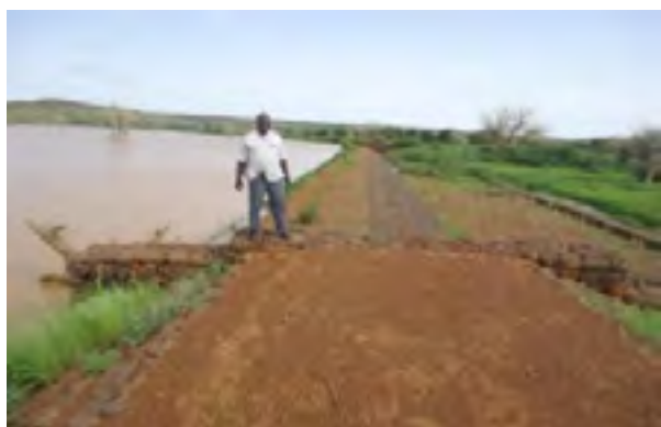
Figure 8 : Seuil d'épandage des eaux de crues dans la vallée de Bagaye, Niger (Source : FAO et IESA)
