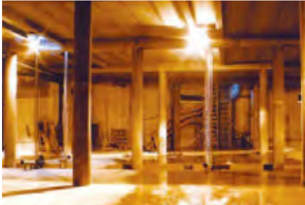
Figure 4 : Intérieur du bassin d'orage Joffre, Loos, France (Source : Soletanche - Bachy)
