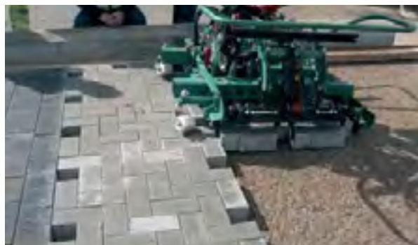
Figure 5 : Pavage mécanique (Source : CRR, 2009)
