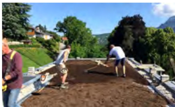
Figure 6 : Plantation des végétaux sur un substrat de toiture végétalisée (Source : https://www.toiture-bio.com/ )
