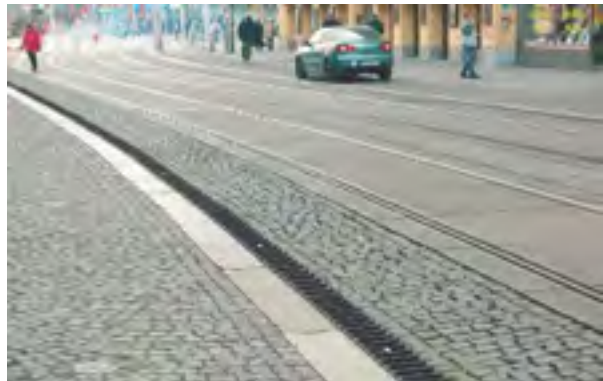
Figure 1 : Caniveaux construits dans une zone habitée (Source : Nicoll, 2008)
