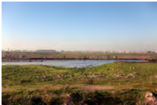
Figure 4 : Bassin de rétention et de régulation, région de Casablanca, Maroc (Source : AGIRE/MAROC)
