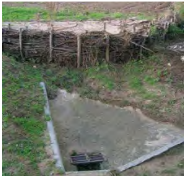
Figure 10 : Fascine pour limiter les coulées boueuses vers l'égout, France (Source : AREAS, 2012)
