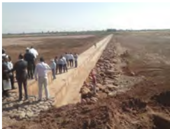
Figure 1 : Seuil d'infiltration réalisé au niveau de l'oued Ghmat, bassin du Tensift, Maroc (Source : ABHT, 2011)
