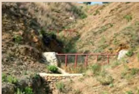
Figure 13 : Ouvrage métallique (Source : HCEFLCD)
