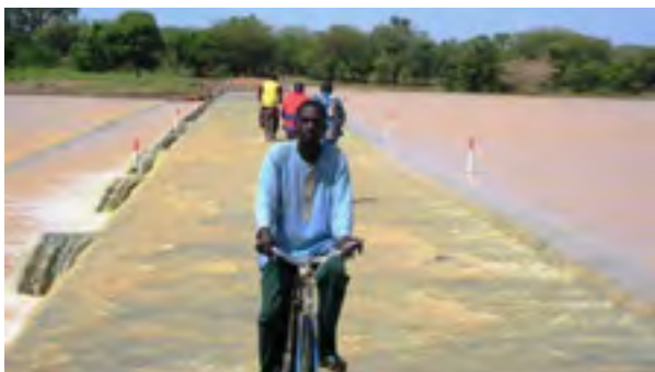
Figure 5 : Seuil d'épandage : pendant la saison des pluies la crête sert de passage à la population en temps de crue (Source : Bender, 2009)
