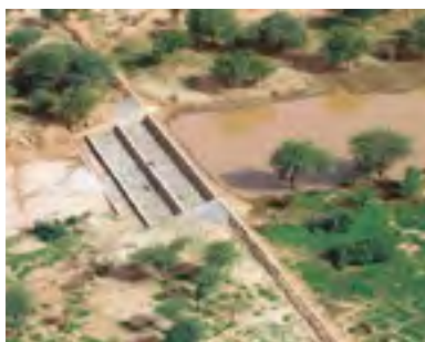
29. Seuil d'épandage des eaux de crues
