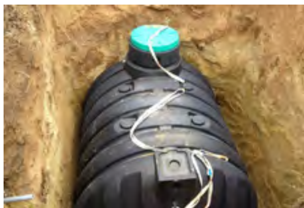
Figure 5 : Pose du réservoir de stockage (Source : https://blog-maison-ecologique.fr/maison-ecologique/maison-ecologique-installation-dune-cuve-enterree-de-recuperation-deau-de-pluie )
