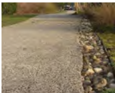
08. Tranchée d'infiltration
