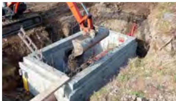
Figure 8 : Construction d'un déversoir d'orage, Givros (Source : SYSEG, 2012)
