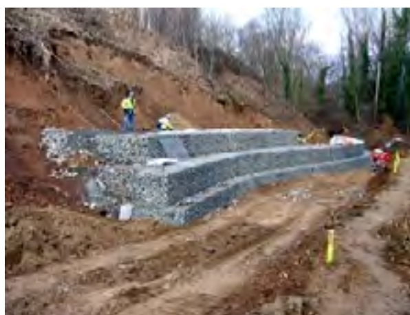
Figure 4 : Construction en cours d'un mur de soutènement en gabions
