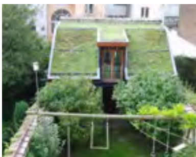
01. Toiture verte / végétalisée
