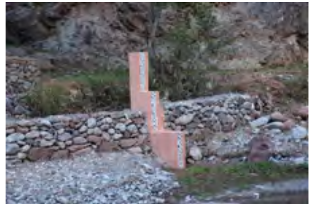
Figure 1 : Seuil en gabions construit, Ourika, Maroc (Source : GIZ/AGIRE)
