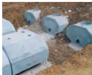
11. Ouvrages de stockage d'orage
