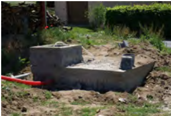
Figure 6 : Construction achevée d'un réservoir de stockage d'eau de pluie ( http://royaumedeoile.fr/maison/une-cuve-a-eau-de-pluie/ )
