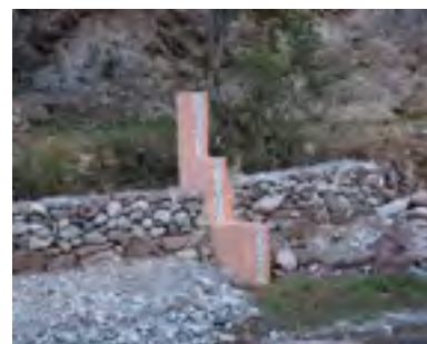
45. Seuil en Gabions
