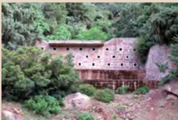
Figure 12 : Mur en maçonnerie (Source : HCEFLCD)
