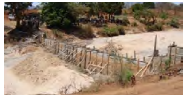
Figure 5 : Construction du mur du barrage (Source : Stern)
