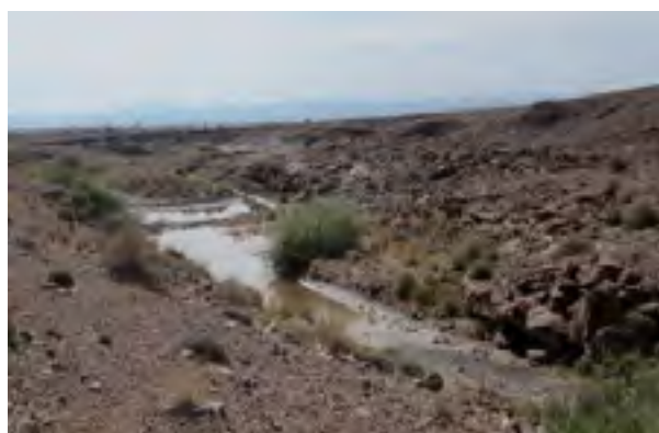
Figure 7 : Seuil d'infiltration construit au village de Tidrhest, projet Captage de l'eau et renforcement de l'agriculture oasienne dans la région d'Ouarzazate, 2013 (Source : GIZ/AGIRE)
