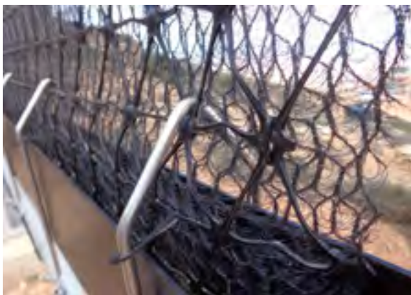
Figure 4 : Détail d'un filet Cloudfisher® (Source : Association Dar Si Hmed)
