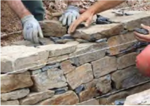
Figure 6 : Construction d'un mur en pierres sèches (Source : Alava et al., 2009)
