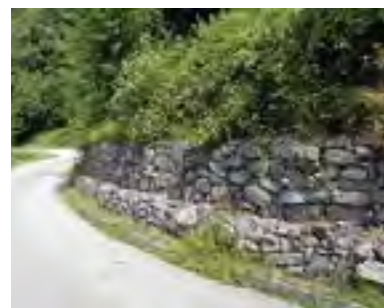
46. Mur de soutènement en gabions
