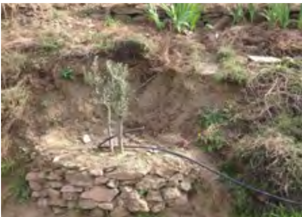
Figure 7 : Murs de soutènement en pierres, Tiznit Tichka, Maroc (Source : Stabilisation des talus pour la pratique agricole, 2014)
