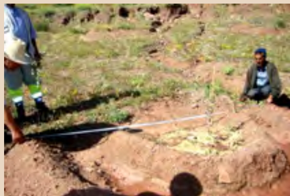
Figure 18 : Confection et supervision des impluviums et cuvettes
