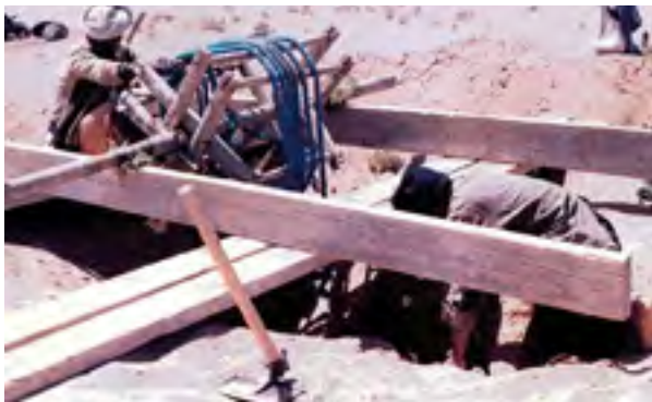
Figure 7 : Curage d'une khattara dans la région du Tafilalt (Source : ORMVA Tafilat, 2001, http://docnum.univ-lorraine.fr/public/NANCY2/doc342/2008NAN21005_3.pdf )
