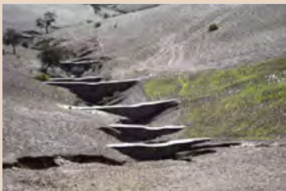
Figure 14 : Série de murs en maçonnerie le long d'un ravin reboisement suivant les courbes de niveau (Source : HCEFLCD)
