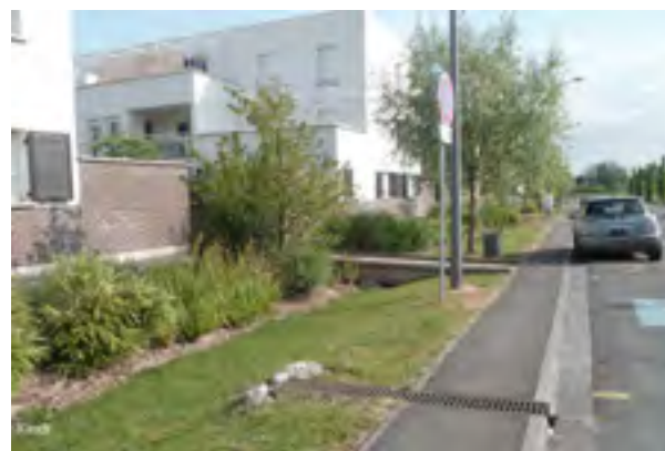
Figure 6 : Noues devant les habitations, Villeneuve d'Ascq, France (Source : NORPAC et IDDR)
