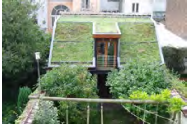
Figure 1 : Toiture végétalisée (source : Inter-Environnement Bruxelles - Aménager votre habitation pour mieux préserver le « patrimoine-eau » de la région. http://www.ieb.be/IMG/pdf/gestioneaupluie.pdf )
