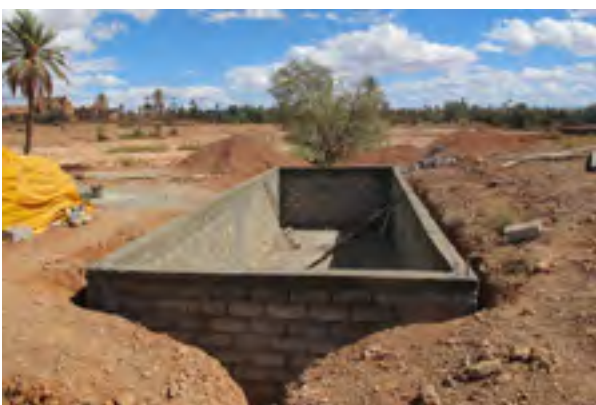
Figure 5 : Matfia construite au village de Tidrhest, projet Captage de l'eau et renforcement de l'agriculture oasienne dans la région d'Ouarzazate, 2013 (Source : GIZ/AGIRE)
