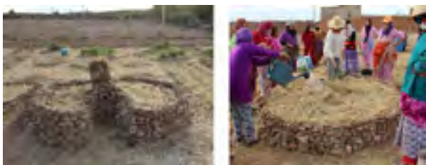
Figure 3 : Construction d'un jardin en trou de serrure (Source : AFEMAC Maroc)
