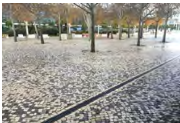
Figure 7 : Caniveau construits en zone urbaine, Lisbonne - Portugal (Source : GIZ/AGIRE)
