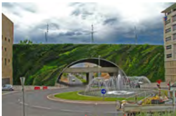
Figure 4 : Pont Max-Juvenal avec le mur végétal, Aix-en-Provence (Source : http://www.monclimatmasante.qc.ca/murs-vegetalisés-à-aix-en-provence.aspx )
