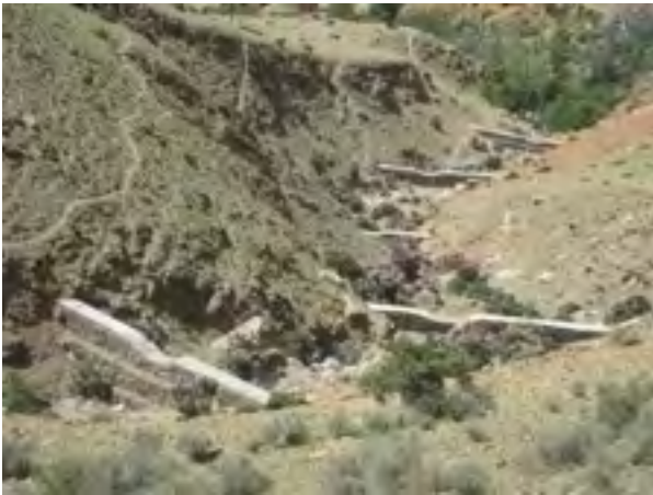
Figure 3 : Succession de seuils en gabion à la vallée d'Ourika (Source : Ph. El Hassan Berhili - Mai 2014)
