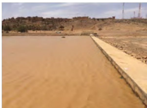
Figure 4 : Retenue d'eau en amont du seuil construit en aval du barrage souterrain à Taghbalt, Province de Zagora, Maroc (Source : MDCEau/DAH/Division des petits et moyens barrages)
