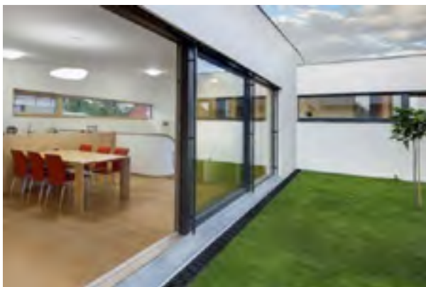
Figure 4 : Caniveaux construits dans une zone habitée (Source : http://shimlapinks-london.com/caniveau-extra-plat-pour-terrasse.html )
