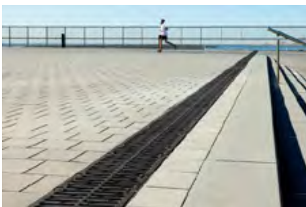
Figure 5 : Caniveaux construits en bordure d'une terrasse (Source : ULMA, 2012)
