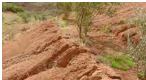
Figure 4 : Banquettes sur forte pente non entretenues et ravinées, Khénifra, Maroc (Source : GTZ/MEDA)
