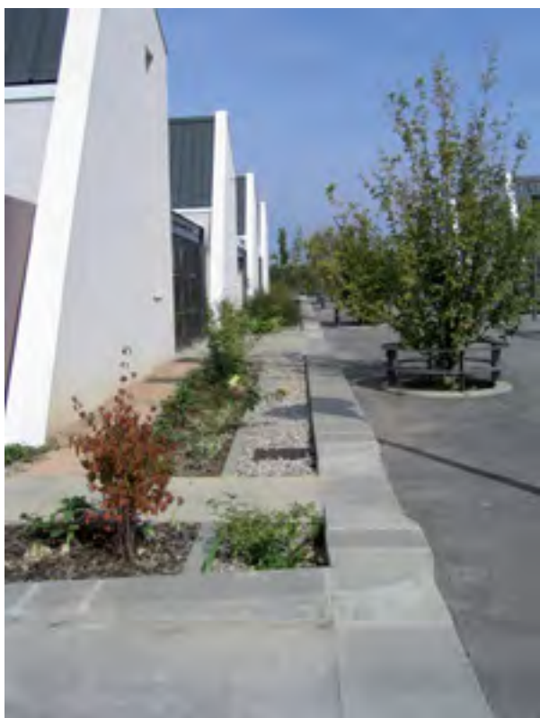
Figure 4 : Tranchée d'infiltration le long des bâtiments (Source : Grand Lyon, 2008)
