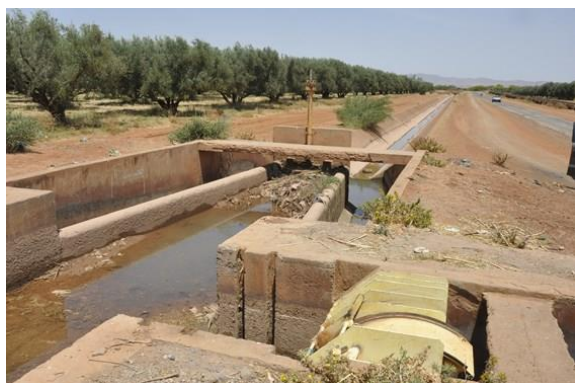
Photo 5 : Prise d'eau à l'amont d'un Giraudet, à la rive droite du canal ouest Source: Étude Soprolive, RESING, 2014
