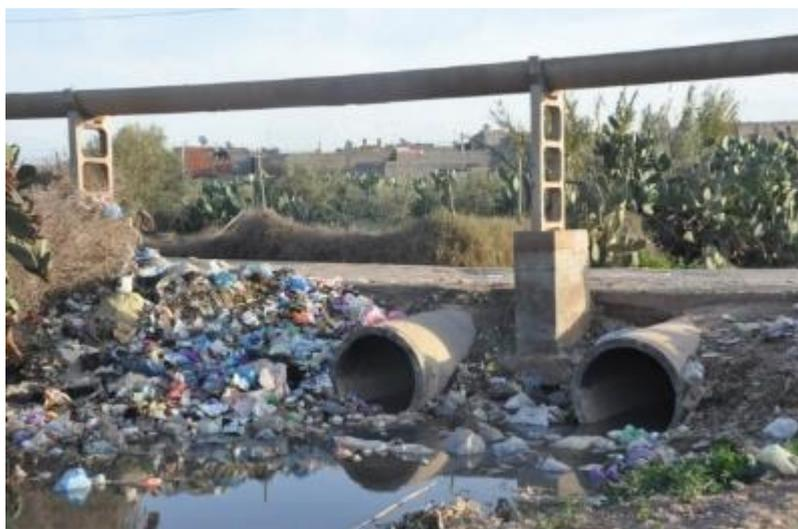
Photo 12 : Rejets d'eaux usées à l'air libre au niveau de Douar Zembrane situé dans la ceinture verte
