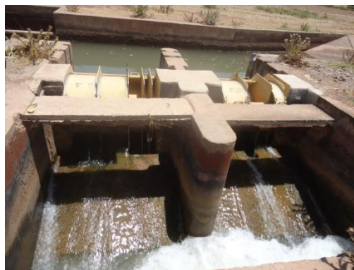
Photo 2 : La prise d'eau vers seguia Sultania au niveau du partiteur Ouled Maazouz Source: Etude Soprolive, RESING, 2014
