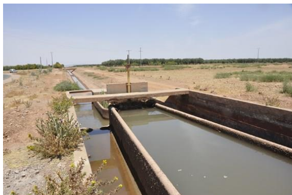
Photo 1 : Partiteur Ouled MAazouz sur le canal Ouest Source: Etude Soprolive, RESING, 2014
