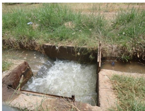
Photo 4 : Arrivée de la seguia Sultania à la ferme SOPROLIVE à Tamallalt Source: Etude Soprolive, RESING, 2014
