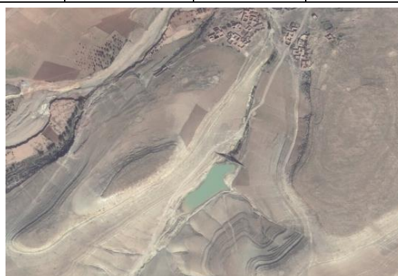
Photo 6 : Barrage Sidi Abdellah Oual source : Vue satellitaire, ArcGis
