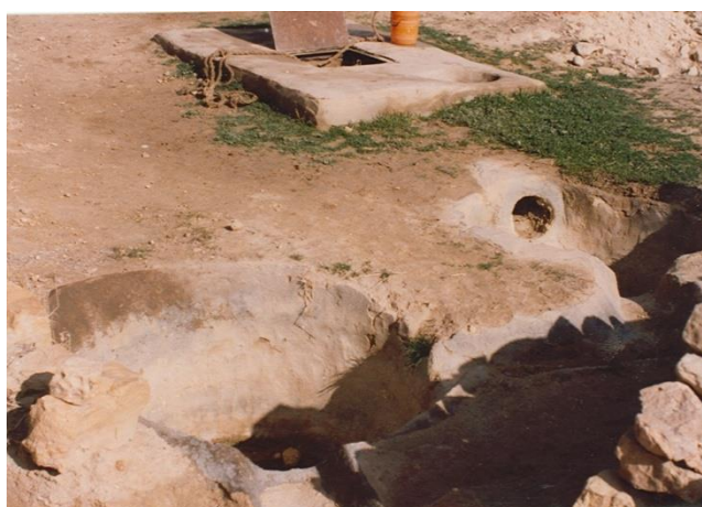
Photo 2 : Système adducteur de metfia, Commune de Taouloukoulte-Province Chichaoua (source RESING, 1992)
