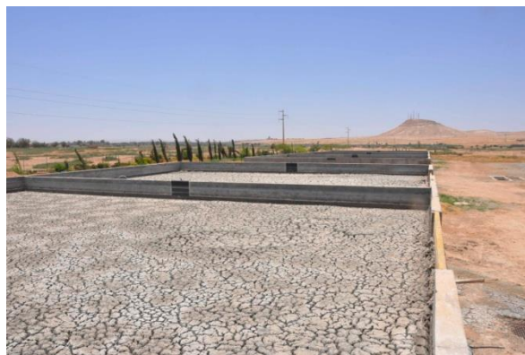
Photo 8 : Bassins de séchage des boues, Source : ONEE-Eau, 2015
