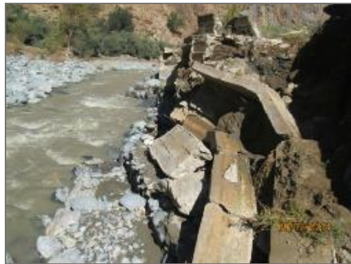
Photo 5 et 6 : Dégâts sur les seguias après la crue exceptionnelle de 2014 (Commune rurale Adassil). Source : Questionnaire Commune, ABHT/GIZ, 2014.
