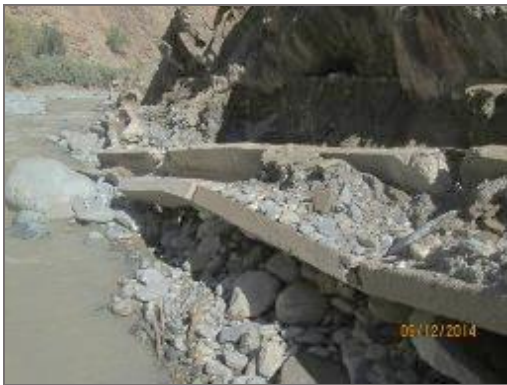
Photo 5 et 6 : Dégâts sur les seguias après la crue exceptionnelle de 2014 (Commune rurale Adassil). Source : Questionnaire Commune, ABHT/GIZ, 2014.
